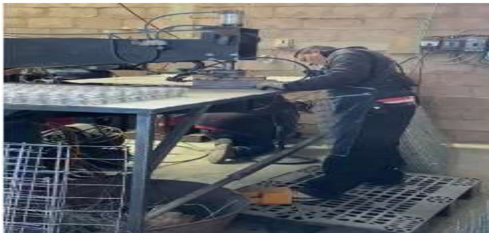
Ilustración 19. Proceso de soldadura en la multipunteadora.
